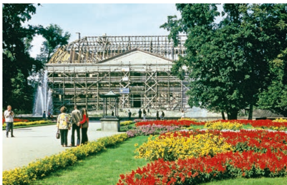
Schlossansicht von Süden beim Aufbau des Dachstuhls, die Dreiecksgiebel werden neu aufgemauert.
