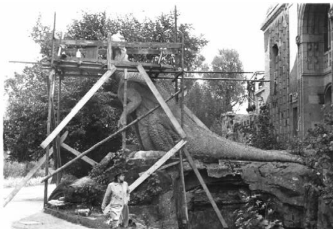
Rekonstruktionsarbeiten am Iguanodon.
