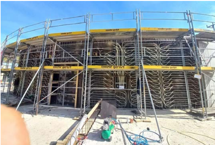
Über 13 km Leitung wurden in den Wänden der Meranti-Halle verlegt. Foto: Hugo-Essing-GmbH
